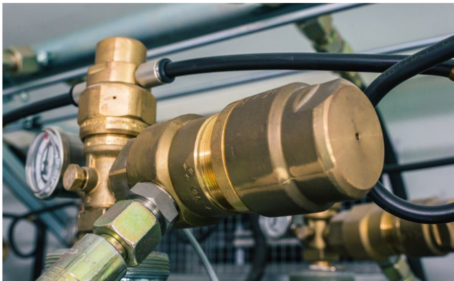
Durchflussregler für Softflutung
