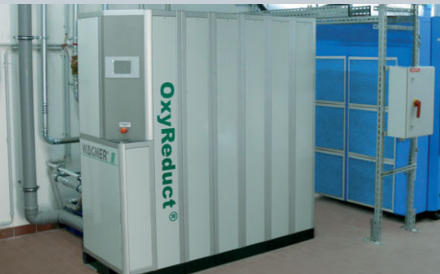
Stickstoffgenerator (links) zur Stickstoff-erzeugung, eine der Kernkomponenten einer OxyReduct® Brandvermeidungs-anlage
