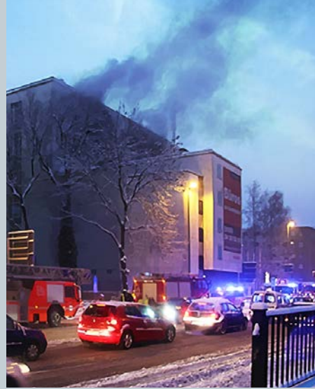
▲ Der Brand in der Telekom-Vermittlungsstelle in Siegen am 21.01.2013 verursachte in der regionalen Wirtschaft Schäden in zweistelliger Millionenhöhe. Laut Umfrage der IHK Siegen waren 95 % der befragten 1.300 Unternehmen von den Ausfällen betroffen
